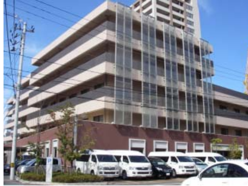
施設全景 (処理機 × 4 基)
