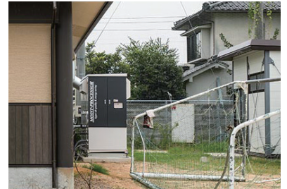
グラウンド側から見る
